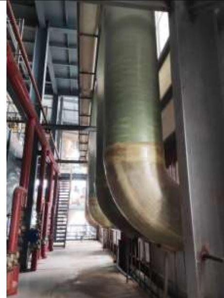
干燥废气收集管道
